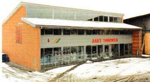
1988: Ny hal er færdig. Nu byggemarked.
