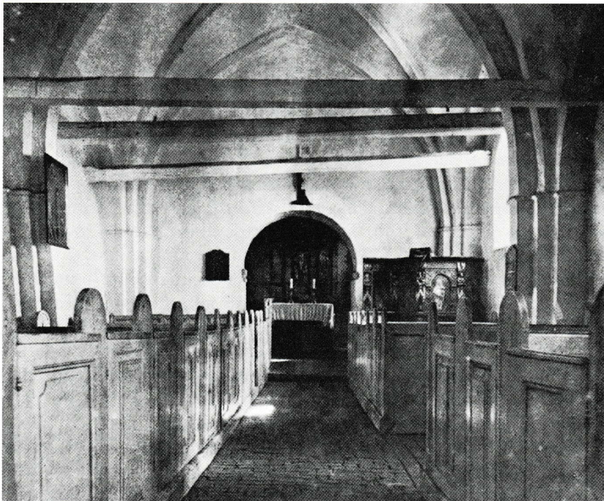
Den 1872 nedrevne kirke. Interiør mod øst, taget umiddelbart før nedrivning (fig 3).
