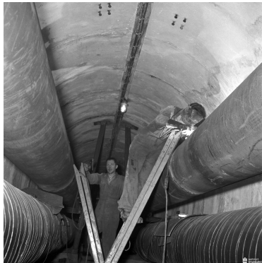
Fra en tunnel.
