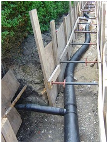
Fjernvarmerør i haveforening på Amager
