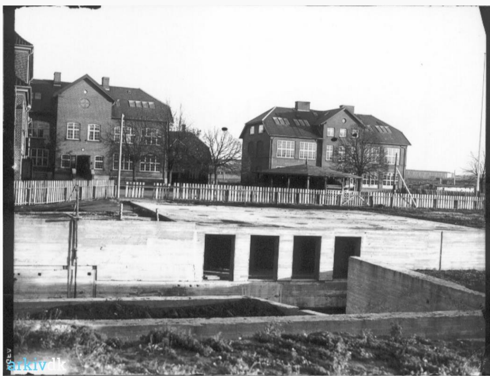
Støbningen af kulkælderen til D-bygningen i 1942 ligger stille på grund af mangel på cement.
