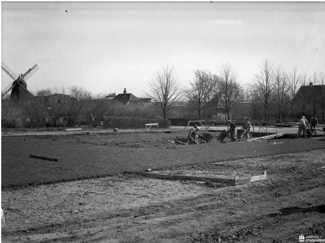
Udgravning af Aabyhøj Kirke den 22. april 1942.
